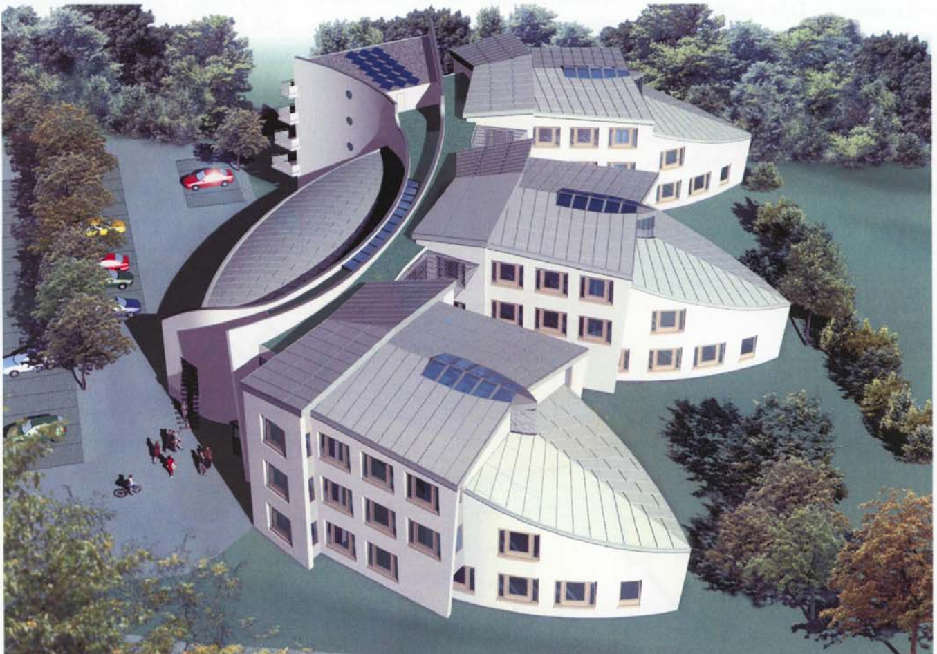
Bild 1: Gebäudekomplex der Gesellschaft für Innovation und Transfer in Siegen
