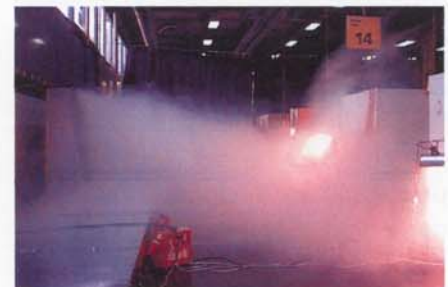
Bild 5: Ausströmen der Zuluft aus dem Luftdurchlass
