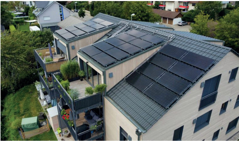
Bild 3: Saniertes Mehrfamilienhaus in Heitersheim bei Freiburg Quelle: Consolar
