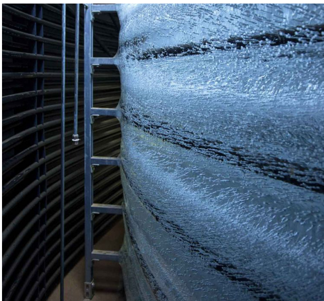
Bild 1: Links: Eisbildung im Eisspeicher (Quelle: Viessmann), Rechts: Eisspeicher im Bau (Quelle: Ulmer/IMAGO)
