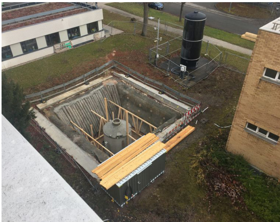
Bild 3: Eisspeicher am IGTE im Bau, Dezember 2020
