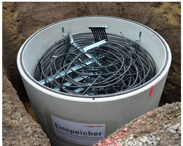
Bild 1: Links: Eisbildung im Eisspeicher (Quelle: Viessmann), Rechts: Eisspeicher im Bau (Quelle: Ulmer/IMAGO)
